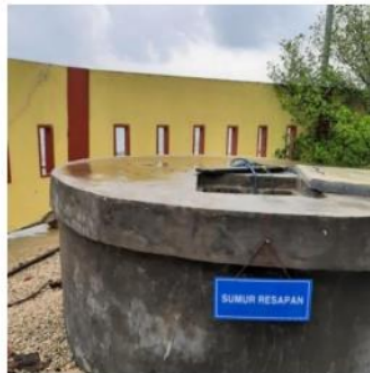
Gambar 3. Sumur resapan untuk proses Intake .
